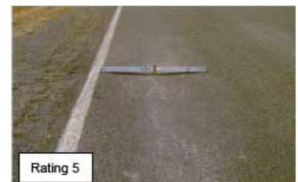
Extreme rutting (average depth > 30 mm.)
